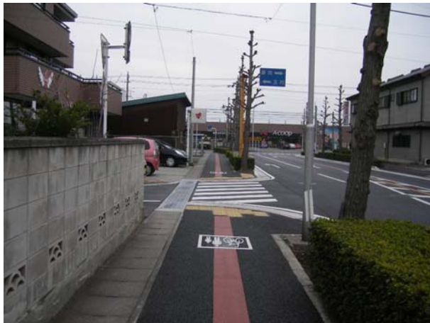
セミフラット歩道への改修
