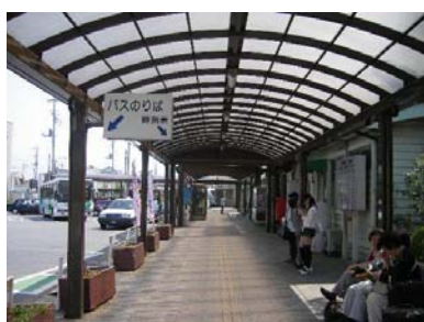
北口駅前広場の状況
