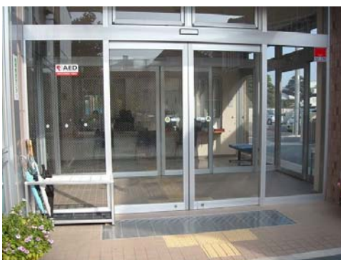
誘導ブロックの敷設された出入口
