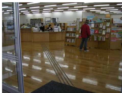
窓口まで誘導する誘導ブロック
