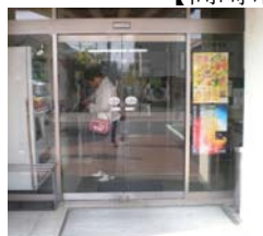
建物出入口 (誘導ブロックなし)
