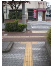
建物出入口 (誘導ブロックが連続していない)
