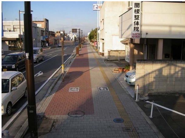
誘導ブロックが敷設され、歩行者通行帯と自転車通行帯に色分けされた歩道
