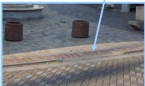
道路と公園との段差すりつけ
