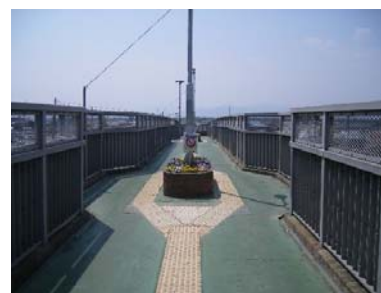
南北歩専橋通路部
