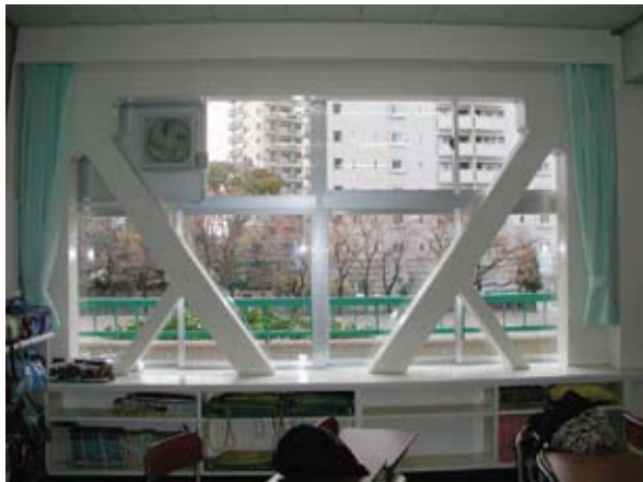
耐震補強施工後の普通教室
