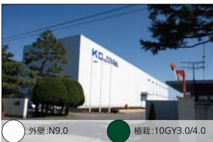
■ 外部からよく見える施設に象徴性のある意匠を採用した工場
