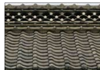
いぶし瓦の色 ※新旧により幅があります 5.0Y4.0/0.5 程度
