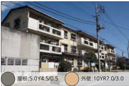
落ち着いた色彩の勾配屋根を採用した集合住宅
