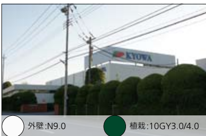
■ 充実した敷地際の緑に白い壁が映える工場
