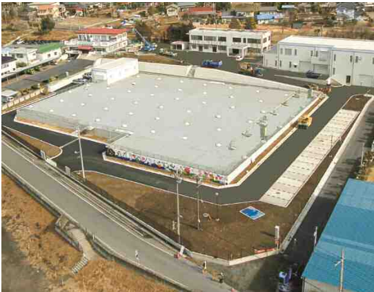
城南雨水滞水池(全景)
