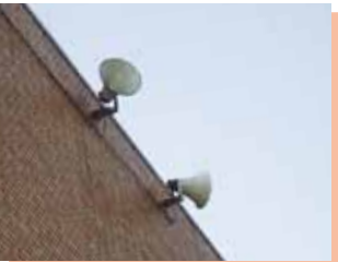
群馬・高崎地域の小中学校などに防災スピーカーを設置 (消防費)
