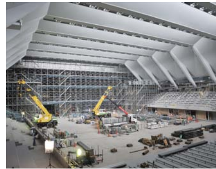
高崎アリーナ建設 (土木費)
