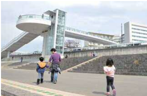
高崎公園と烏川河川敷をつなぐ「桜観音橋」が完成(土木費)
