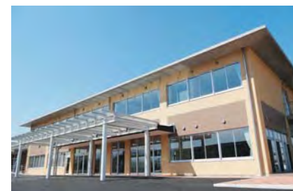
吉井福祉センター・吉井デイサービスセンターを建設(民生費)
