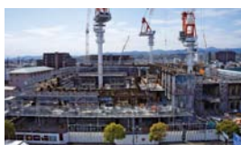
完成に向け、ただ今建設中
