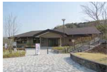
プール営業後も開放している管理棟
