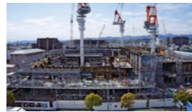
完成に向け、ただ今建設中
