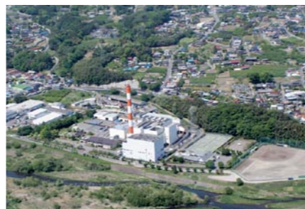
高浜クリーンセンター上空写真
