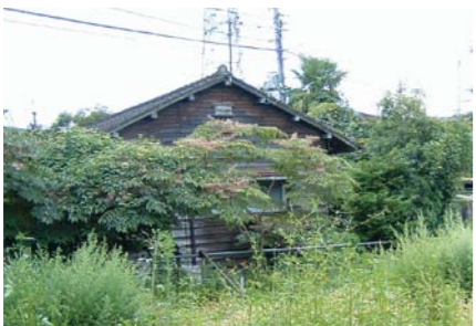
雑草が生い茂る空き家(写真はイメージ)
