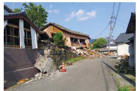
熊本地震で倒壊した家屋と崩れた壁
