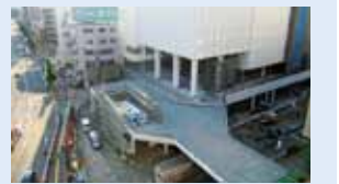
建設が進む西口ペDESTリアンデッキ屋根を設置することになり増額となった。
