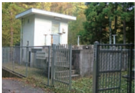
倉淵町三ノ倉の簡水施設
