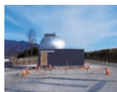
建設が進むくらぶちこども天文台
