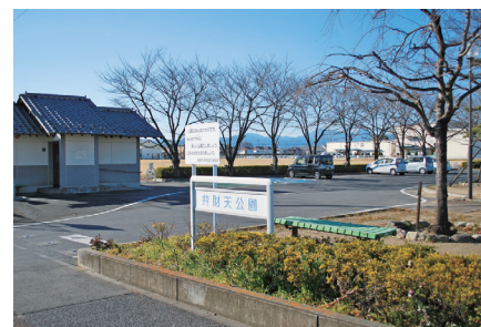
新体育館建設予定地
