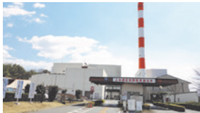
建て替えが始まる 高浜クリーンセンター
