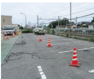
供用が終了となる新町駅東駐車場
