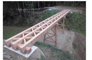
令和2年度に設置した橋脚と橋桁
