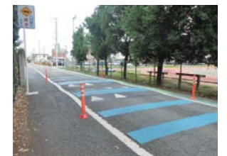
交通安全対策として設置したハンプ
