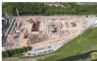
工事が進む高浜クリーンセンター
